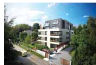
Vila Na Výsluní Novostavba bytového domu – Praha Návrh: Podlipný Sladký architekti s. r. o.
