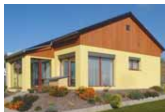
Dřevostavba Střelské Hoštice na betonových patkách Novostavba rodinného domu – Střelské Hoštice Návrh: Karel Račák
