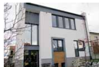
Rodinný dům v Hodoníně Rekonstrukce rodinného domu – Hodonín Návrh: Ing. Arch. M. Opavská
