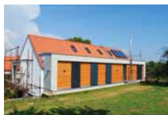
Rekonstrukce chlévů na RD v PAS standardu Rekonstrukce rodinného domu – Vochov Návrh: KUBUS atelier s. r. o.
