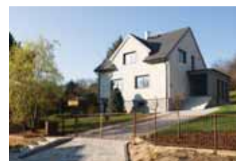
Rekonstrukce domu z 50. let Rekonstrukce rodinného domu – Brušperk Návrh: Tamara Staňková
