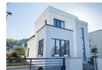
Náš dům Rekonstrukce – Písek Návrh: Franců Tomáš
