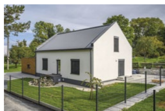
Moderní rekonstrukce rodinného domu Rekonstrukce – Kozlovice Návrh: Ing. Lucie Šnajdrová
