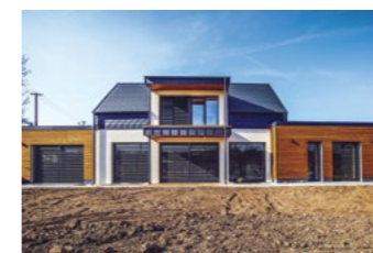
Nízkoenergetický rodinný dům Novostavba rodinného domu – Truskovice Návrh: CB Building
