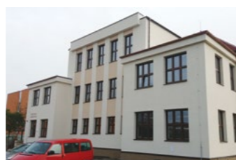
Městská knihovna Žamberk Rekonstrukce – Žamberk
