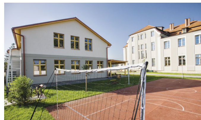
Rozšíření ZŠ Malý Újezd, nový pavilon – pasivní stavba dotace: 7 542 886 Kč
