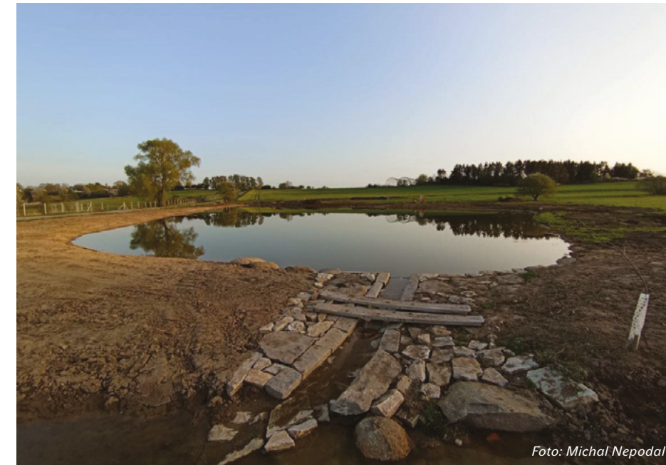
Tůň v Řezinách. V popředí zpevněná přelivná hrana
